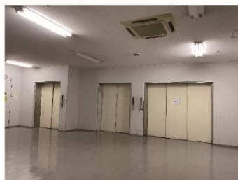
③業務用エレベーターで B1階 へ 3機どれでも使用可能です
